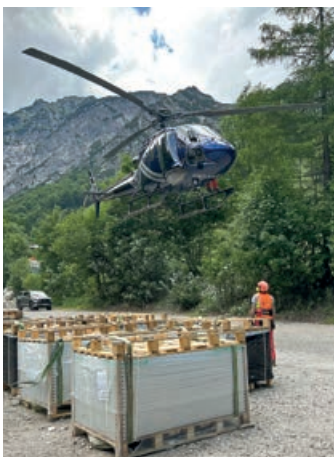
Die schweren Bauteile wurden per Hubschrauber zum Stripsenjochhaus geflogen.
