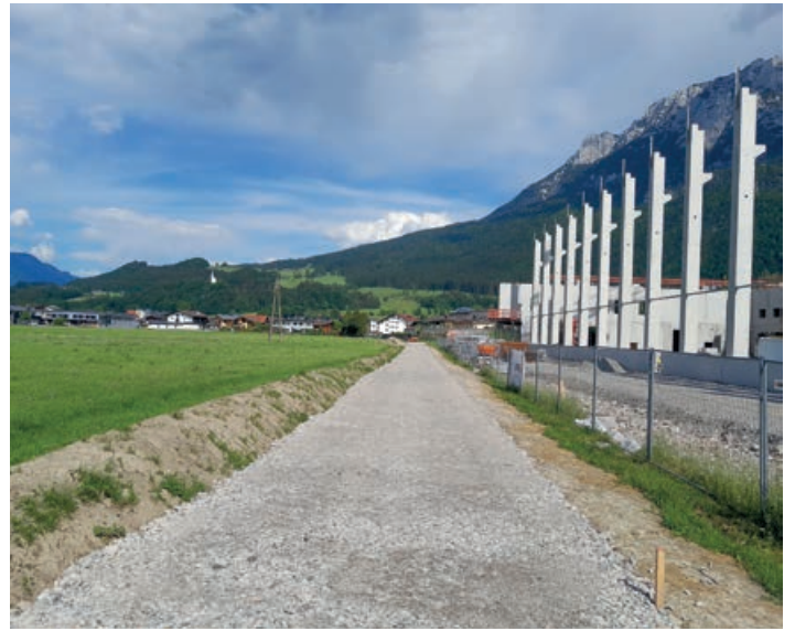
Der neue Radweg nördlich der Gewerbegebietserweiterung ist derzeit in Bau. Es wird daran gearbeitet, dass diese wichtige innerörtliche Verbindung rasch wieder geöffnet werden kann.
