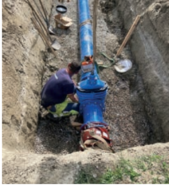
Die neu errichtete Wasserleitung (blau) wurde an die bestehende Leitung angeschlossen (Fotonachweis: Fa. Bodner).
