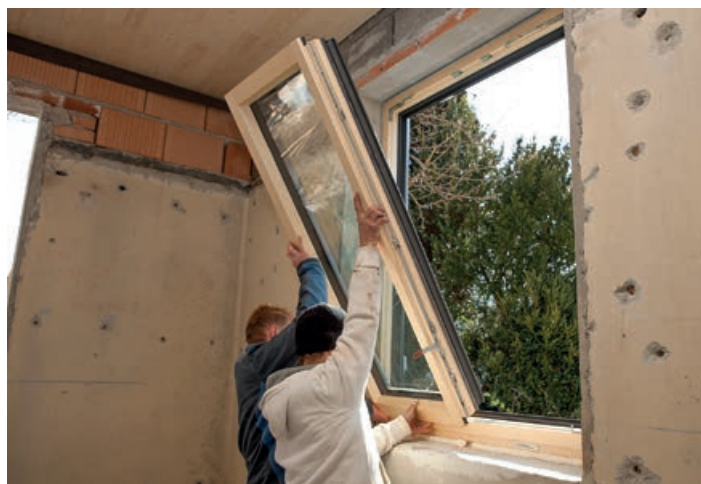
Der Fenstertausch wird idealerweise gemeinsam mit der Fassadendämmung durchgeführt - dadurch können die Anschlüsse optimal und wärmebrückenfrei ausgeführt werden (Fotonachweis: Energieagentur Tirol).
