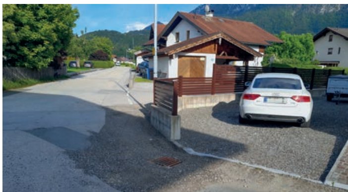
Für die Entwässerung der beiden Einlaufschächte wurde ein Sickerschacht errichtet. Der Deckel ist noch mit Planiermaterial überdeckt. Die Asphaltierungsarbeiten hierzu starten in Kürze.
