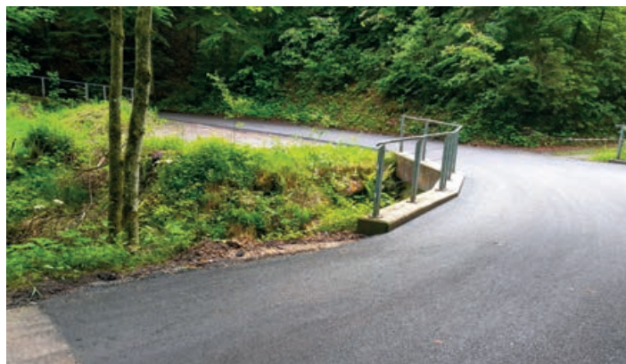
Im Bereich Oberbuchberg wurde die Fahrbahnoberfläche saniert, ...
