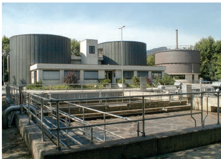
Die Verbandskläranlage in Niederndorf.
