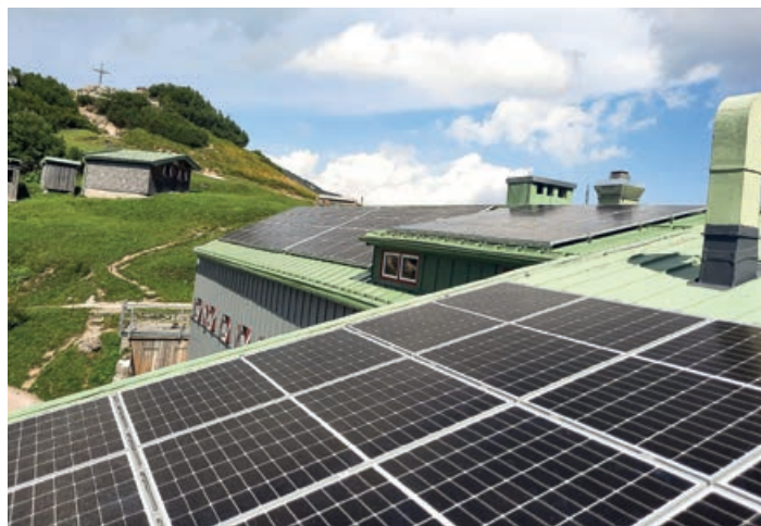
Eine 35 kWp starke Anlage deckt nun einen großen Teil des Energiebedarfs der Hütte ab. Installiert wurde die Anlage von der Firma Strom vom Dach aus Erl.
